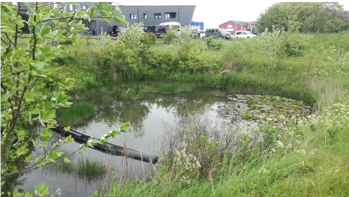
Foto 3: Regenrückhaltebecken mit offener Wasserfläche im Osten des Geltungsbereichs
