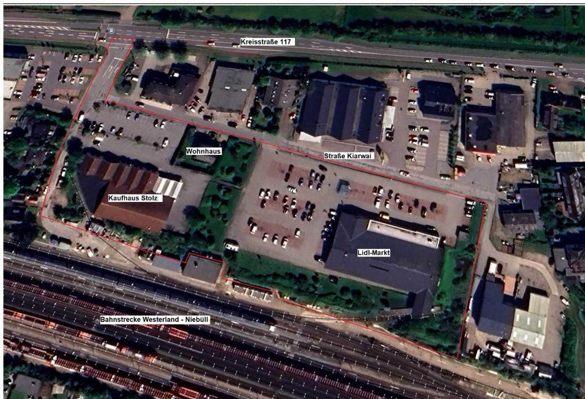
Abb. 3: Bestandssituation im Plangebiet (Quelle Google Earth, Aufnahme vom 5.6.2024)
