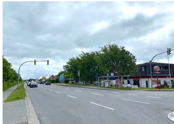
Kreuzungsbereich Keitumer Landstraße / Kiarwai (östliche Blickrichtung)
