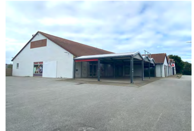
Blick auf das Altgebäude ex KH Stolz des Vorhabenstandortes für den Lidl-Ersatzneubau (westliche Blickrichtung)
