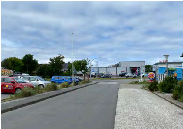
Kiarwai Höhe östliche Einfahrt zum Vorhabenstandort (links) mit Blick auf benachbarten Rewe-Supermarkt nordwestlich des Vorhabens (westliche Blickrichtung)
