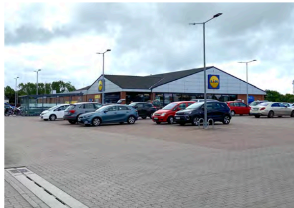
Für einen Drogeriemarkt und eine Apotheke + Shops als Nachnutzung vorgesehene Bestandsgebäude Lidl mit aktueller Parkplatzsituation
