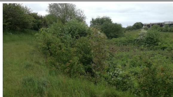
Senke/Retentionsbereich des Regenrückhaltebeckens mit Gehölz- und Schilfbewuchs (außerhalb des Geltungsbereichs)
